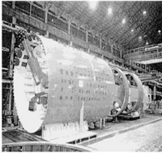
آلة الحفر ECL boring/lining machine.
